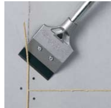
Nästa dag tas överskjutande limfog bort.
