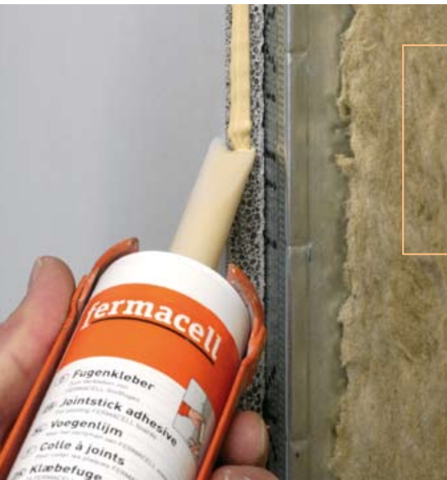
Applicera FERMACELL limfog mitt på skivans kant
